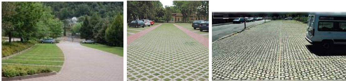
Figura 34 - Esempi di pavimentazioni permeabili
