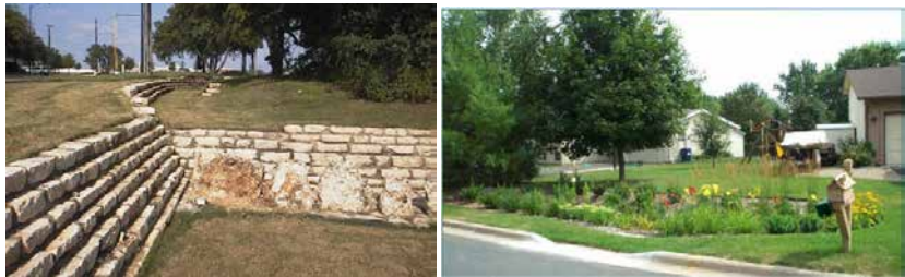
Figura 19 – Esempi di strutture superficiali di laminazione costituite da vasche e canali a cielo aperto
